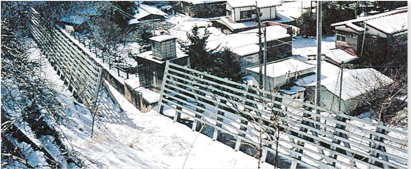
■雪崩防護柵（南巨摩郡早川町白沢）
