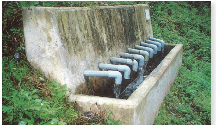
■横ボーリング工（小菅村小永田）
