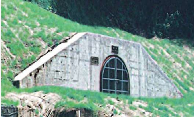
■排水トンネル工（富士川町西沢）
