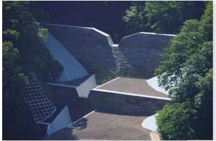
■ 金山沢堰堤（金山沢、南アルプス市駒場）
