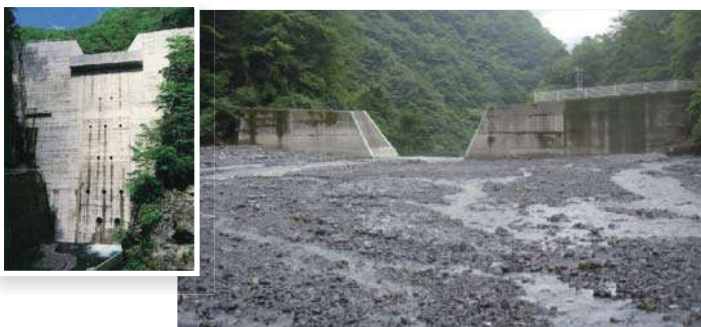
127万 m 3 の土砂を捕捉し、下流への有害土砂の流出を防いでいる稲又第三砂防堰堤
