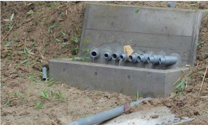
■横ボーリング工（市川三郷町岩間）
