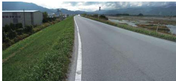
上流荒廃地から流出した土砂の堆積により洪水土砂はん濫被害が起こりやすくなっている釜無川本川の河床上昇の状況
